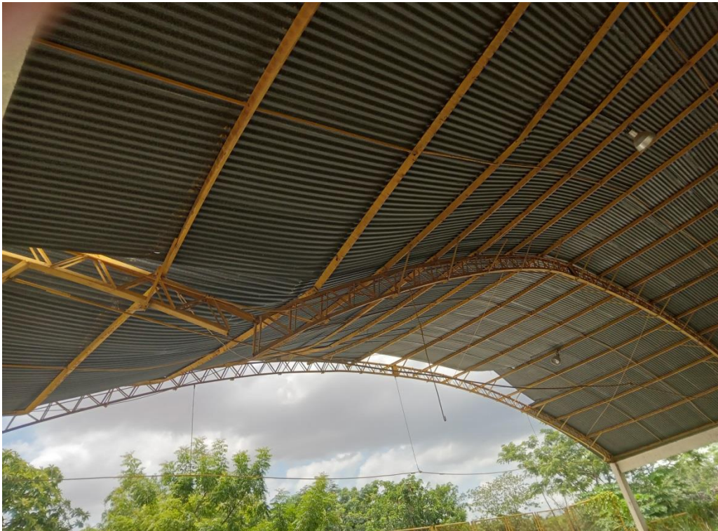
Fotografia 01 – Treliça metálica apresentando rompimento de banzo inferior.
